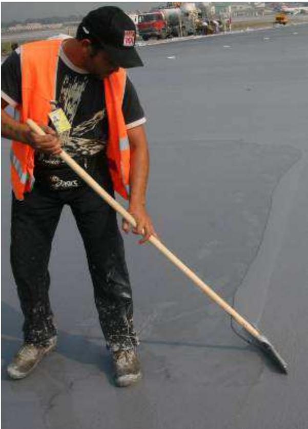
Il risultato finale è uno strato con scheletro litico, costituito da grani di aggregati legati per mezzo della componente bituminosa, racchiuso in una matrice cementizia.
