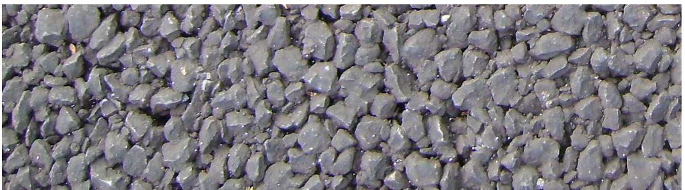
Il completo intasamento dei pori del conglomerato bituminoso è realizzato per mezzo di iniezione di boiaccia cementizia fluida distribuita con racle gommate ed attrezzature adeguate.
